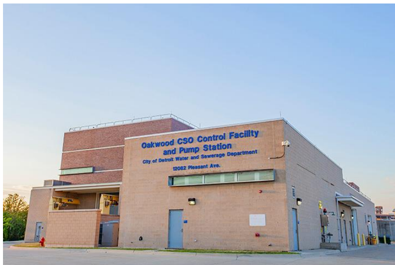
Figure VI-42. Oakwood CSO RTB
