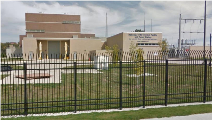
Figure VI-42. Oakwood CSO RTB
